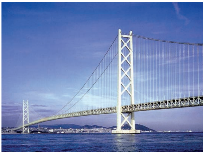
Ponte da Normandia (vão central 856 m).
